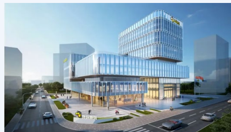
华南运营中心总部大楼（在建）
